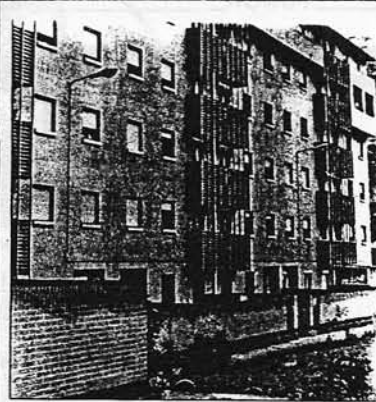
El pasado día 4 se sortearon las viviendas de la segunda fase de remodelación.
