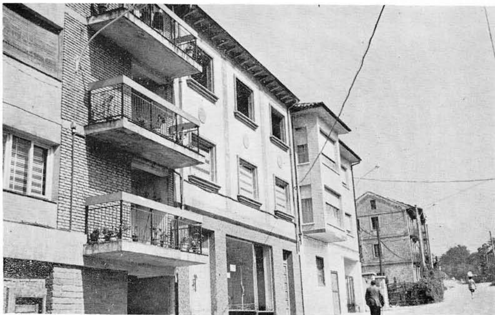
Nueva y moderna instalación de alumbrado público, y, dentro de poco, agua en abundancia... Hay que aplaudir a la Corporación mierense.
