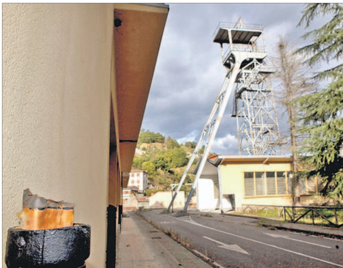
El castillete del pozo Venturo, donde se instaló la cartográfica. | FERNANDO RODRÍGUEZ
