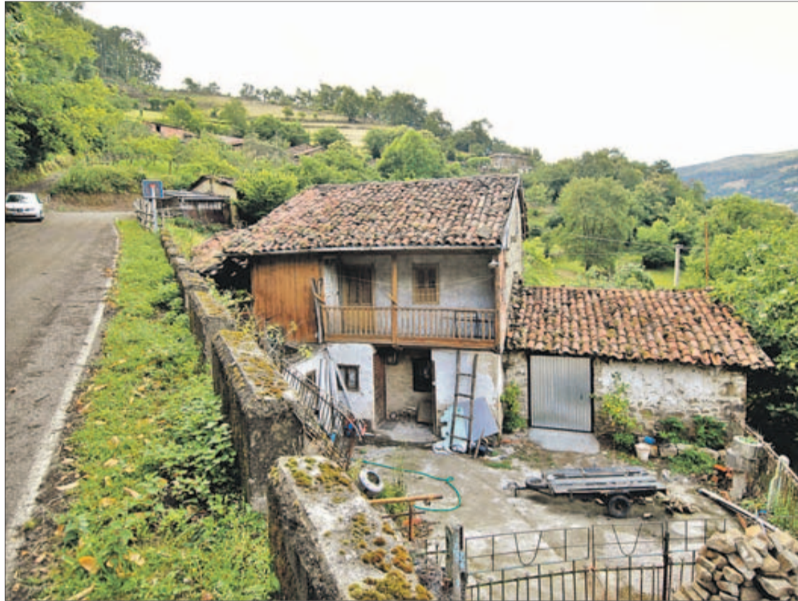
Una casa abandonada en Tablao, uno de los pueblos de Mieres que se han quedado sin vecinos. | FERNANDO GEJÓ
