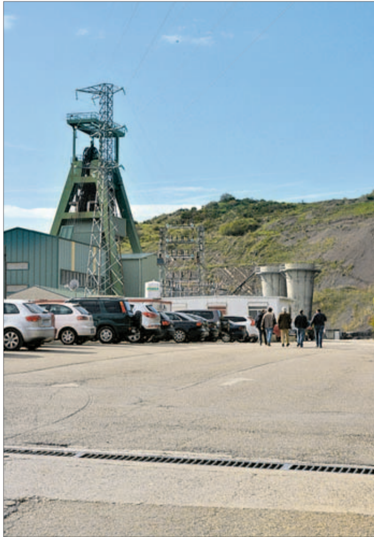
Las instalaciones del pozo Emilio, en La Pola de Gordón. | J. R. SILVEIRA
