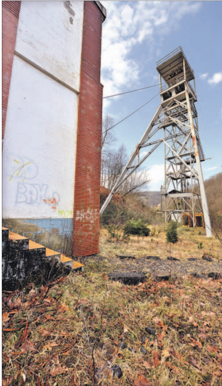
Las instalaciones del pozo Tres Amigos. | J. R. SILVEIRA
