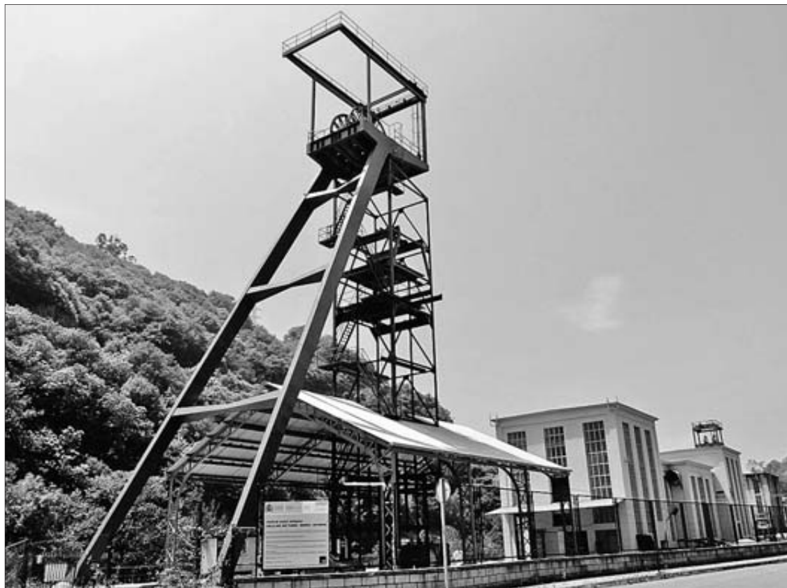
El castillete y la sala de compresores del pozo Santa Bárbara, instalaciones ya restauradas. | J. R. SILVEIRA
