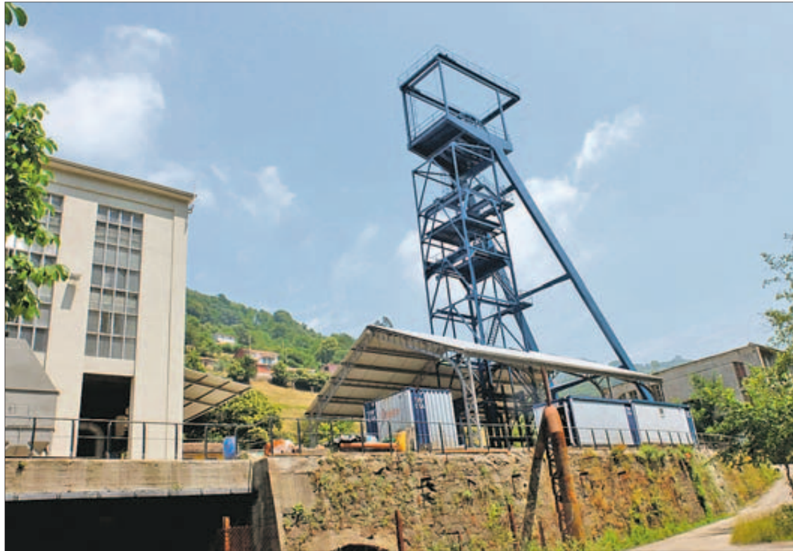
El castillete del pozo Santa Bárbara, ya restaurado. | J. R. SILVEIRA
