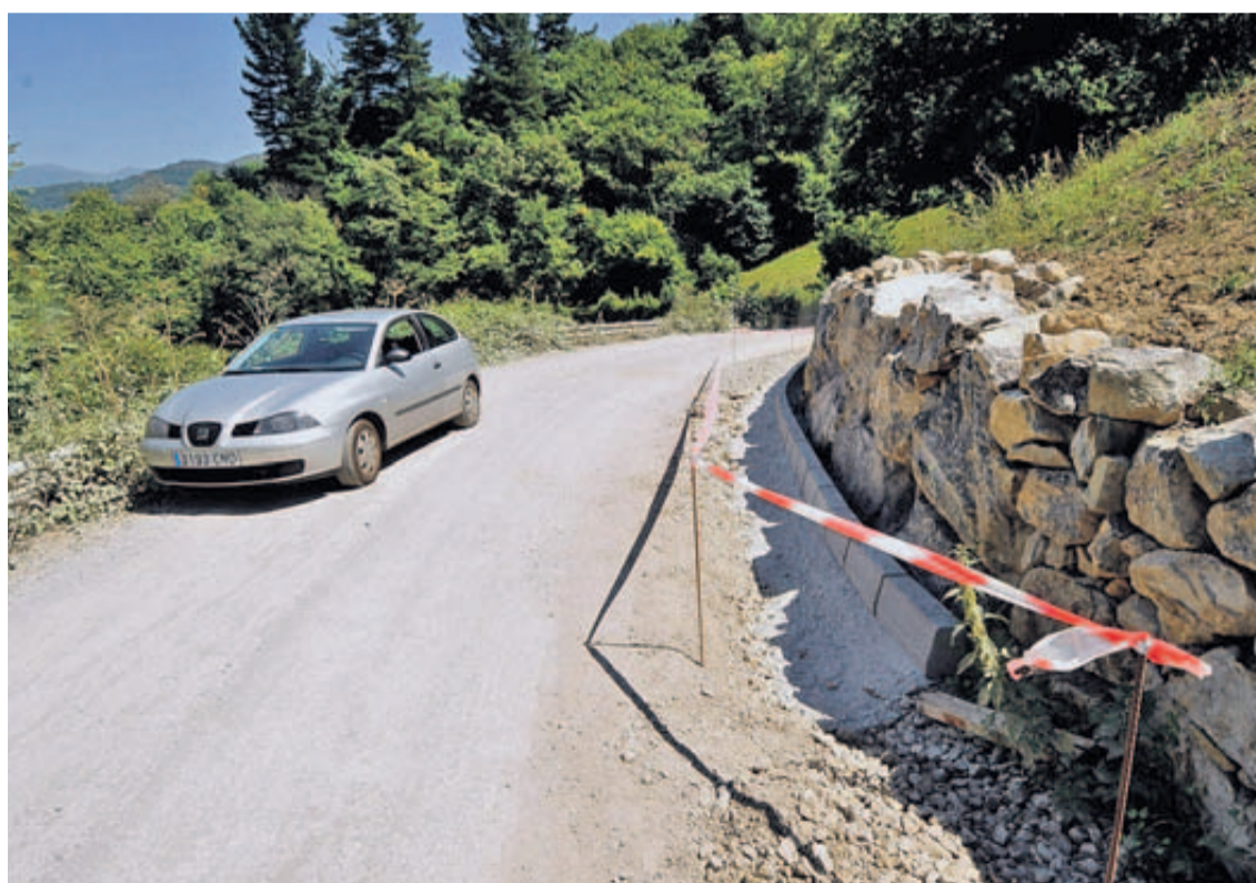
Un coche pasando por la carretera de Zurea el pasado verano, durante las obras. | FERNANDO GEIJO
