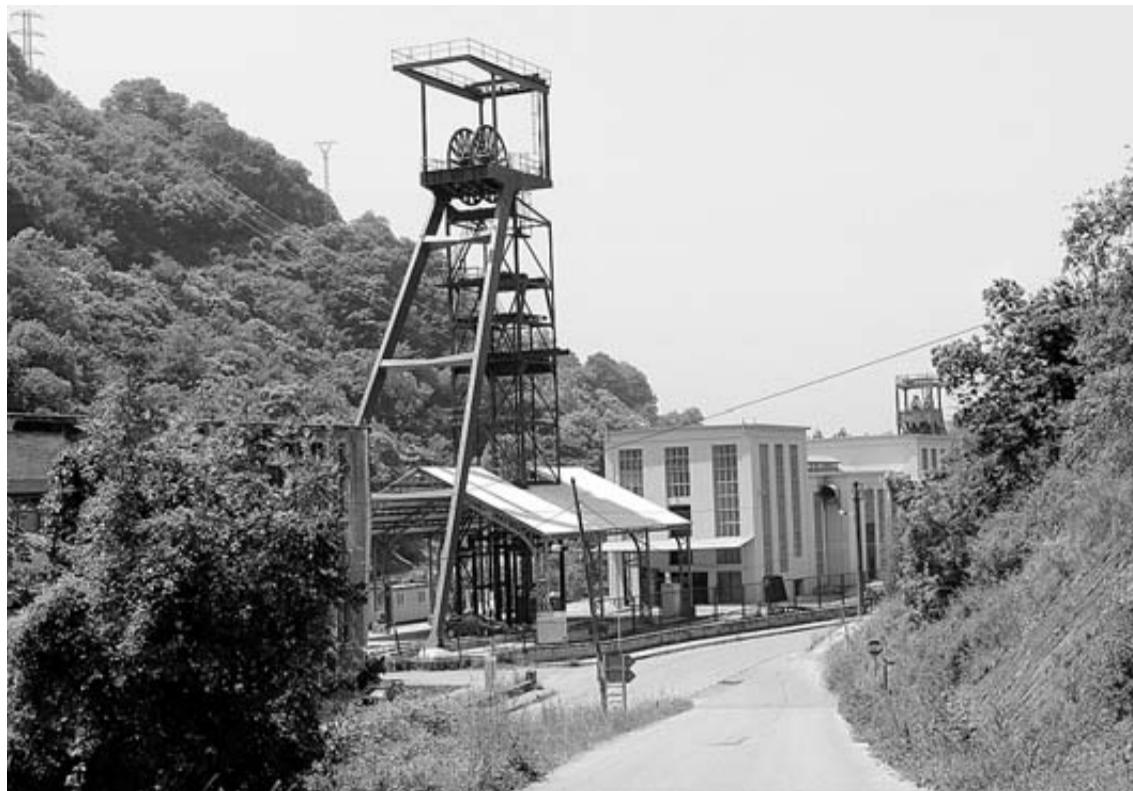
El pozo Santa Bárbara, tras la rehabilitación de las instalaciones. | J. R. SILVEIRA
