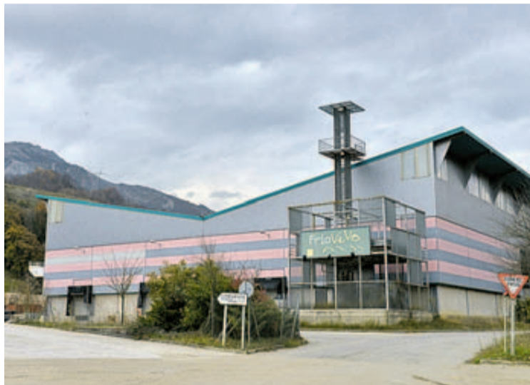
Estado actual de la nave de Friovivo, en Sotiello (Lena). | J. R. SILVEIRA
