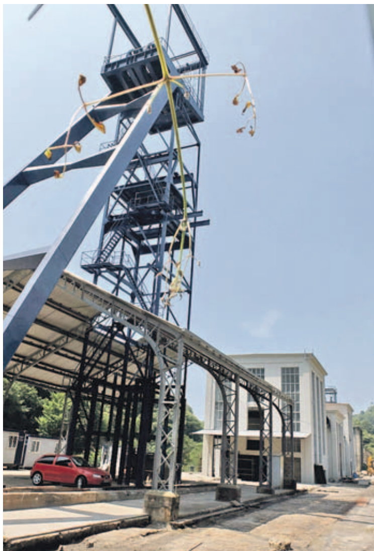
Instalaciones del pozo Santa Bárbara. | J. R. SILVEIRA
