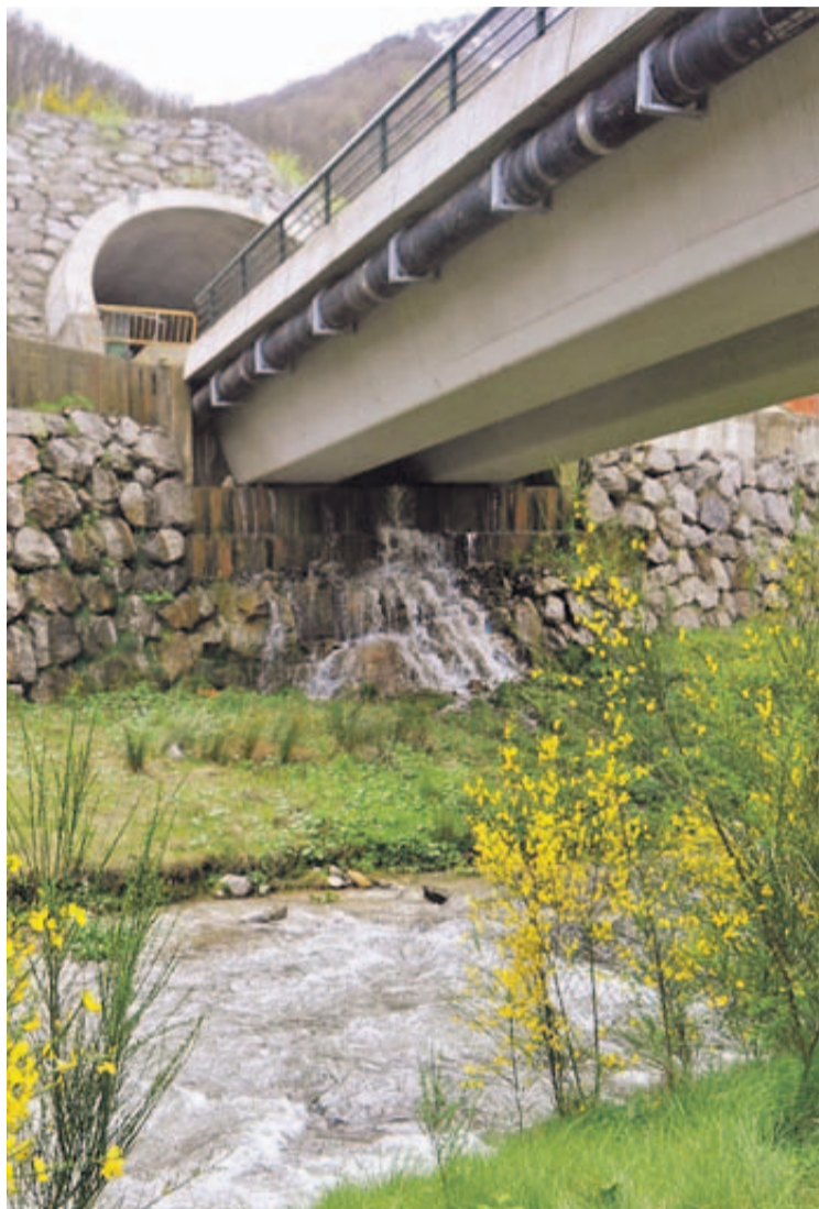
El vertido de agua desde la Variante hacia el río Huerna. | FERNANDO GEJO
