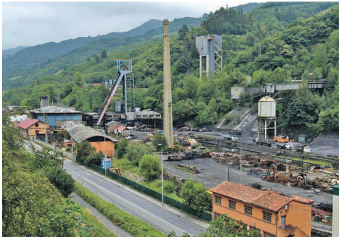
Instalaciones del pozo Figaredo, donde se iba a instalar un centro tecnológico tras su cierre. | FERNANDO GEIJO
