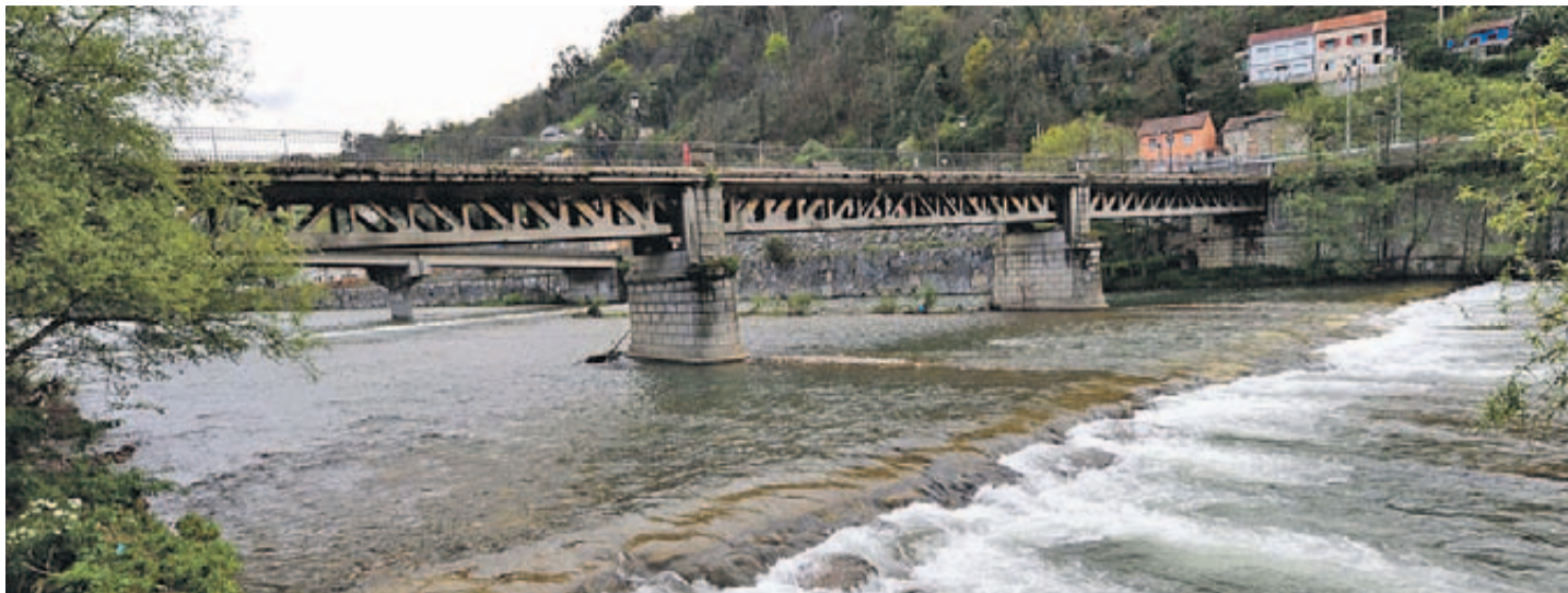
Una vista del puente de La Perra, sobre el río Caudal, en Mieres del Camino. | J. R. SILVEIRA
