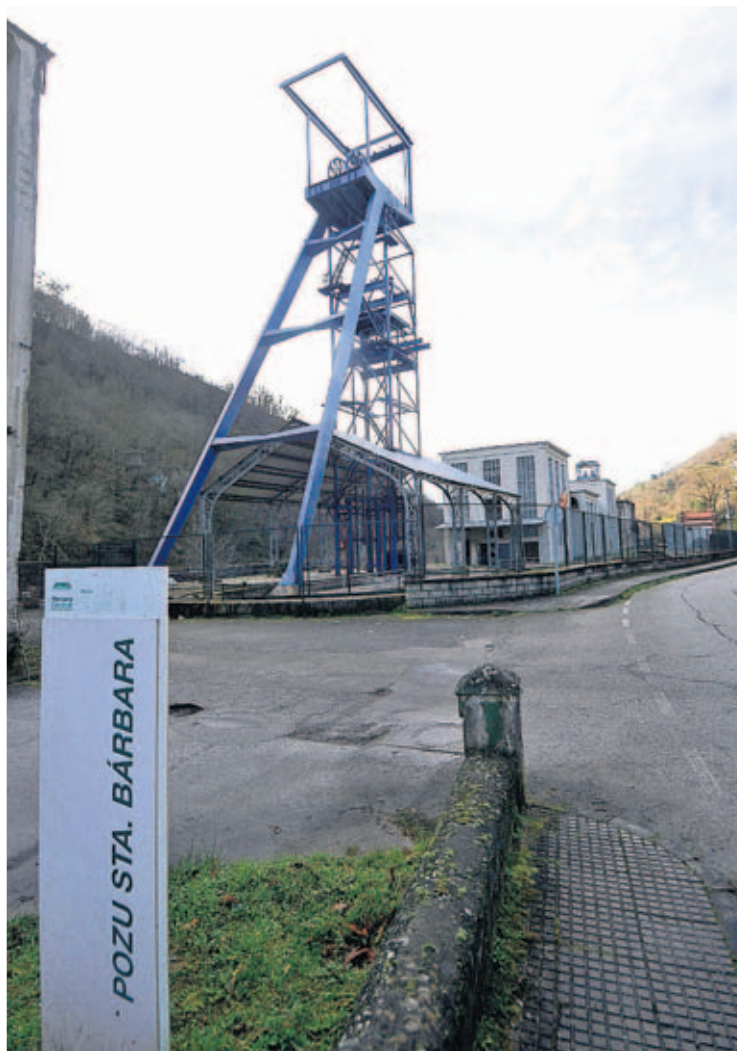
Las instalaciones del pozo Santa Bárbara. | FERNANDO GEIJO
