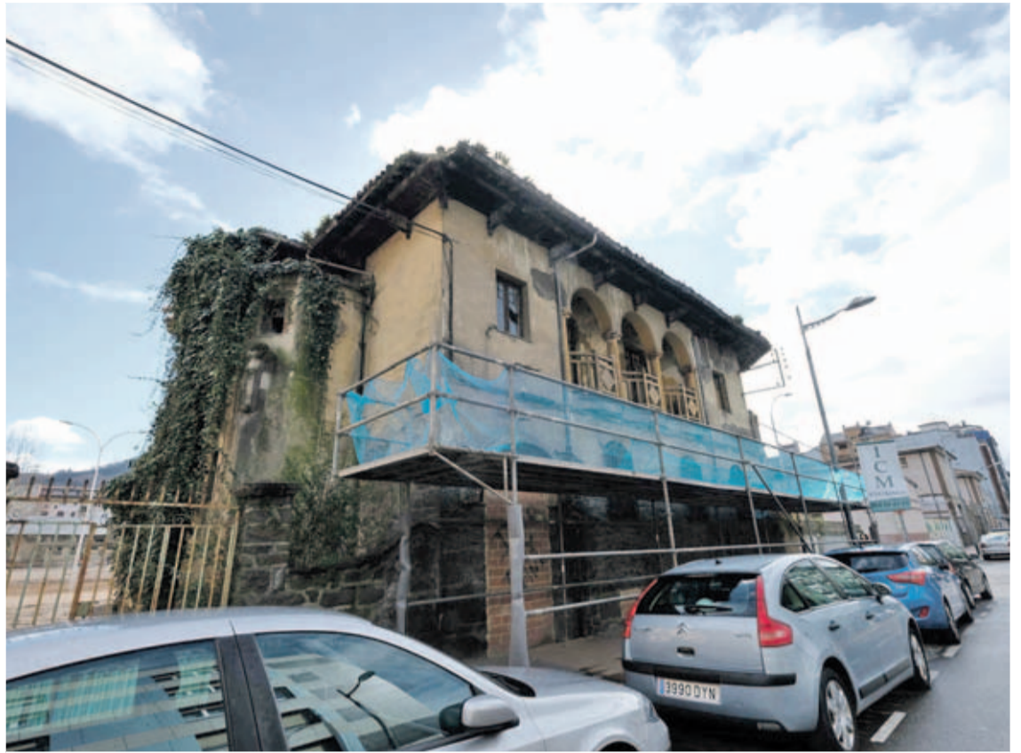
El chalé ubicado en la calle Numa Gilhou, con el andamiaje instalado. | J. R. SILVEIRA
