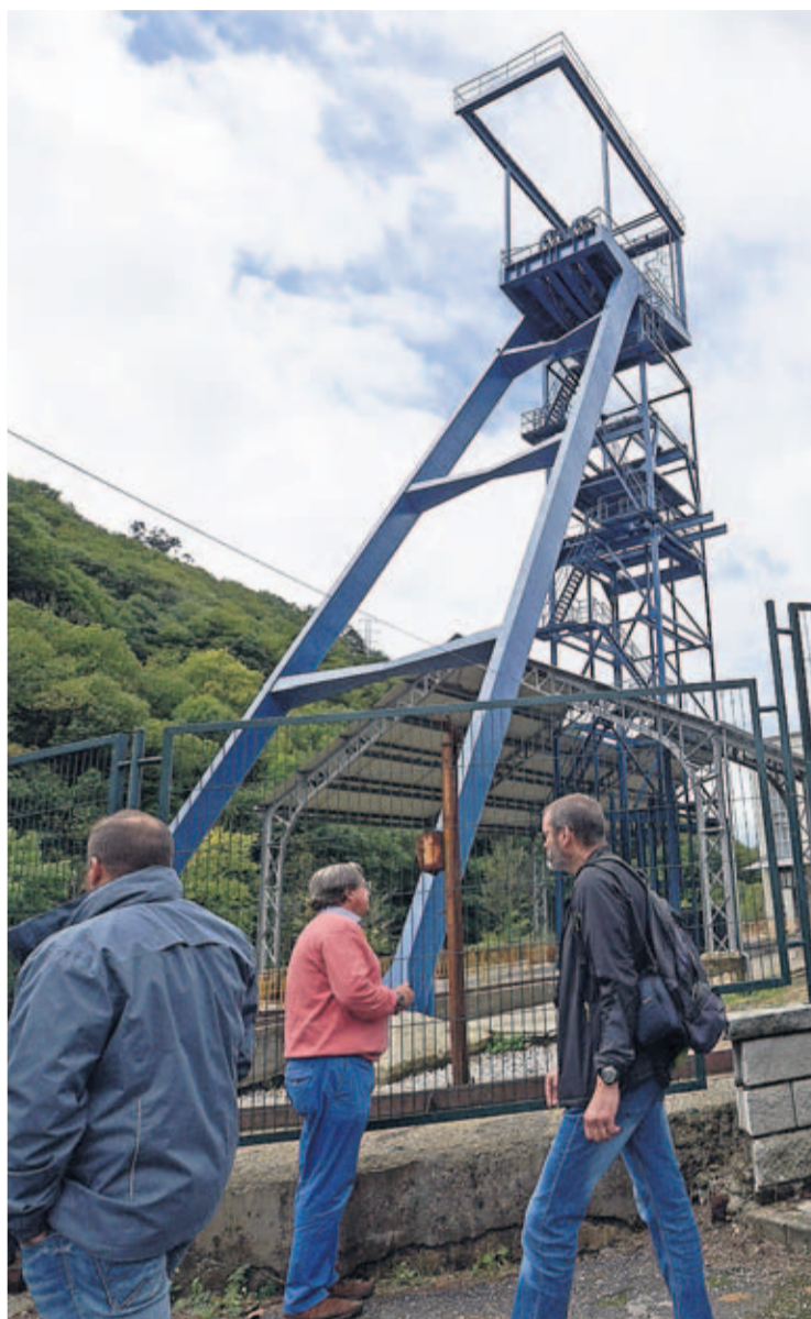
Las instalaciones del pozo Santa Bárbara, en Turón. | FERNANDO GEJO
