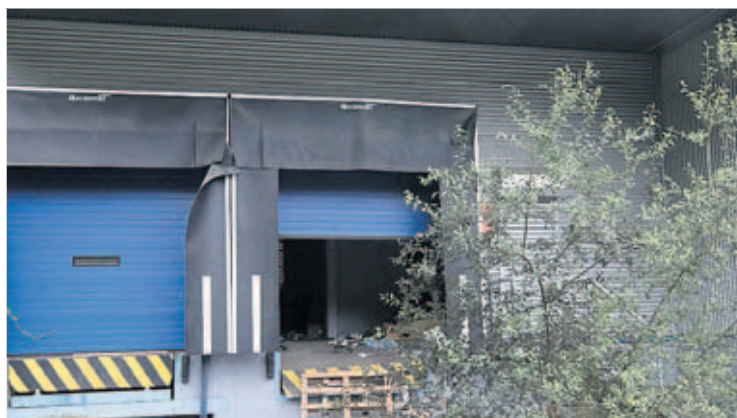
Entrada al almacén principal, con tabloncillos colocados para facilitar el acceso a través de la zona de carga y descarga. | J. R. Silveira
