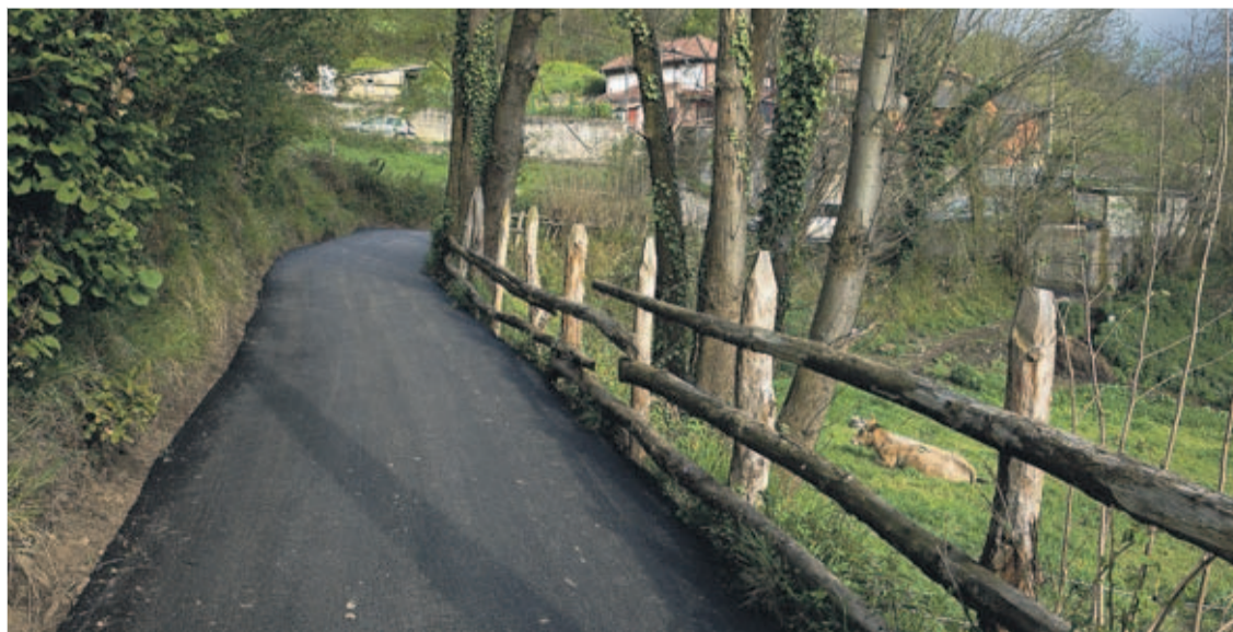
Un tramo de la carretera de Vegalafonte, ya rehabilitada. | Juan Plaza
