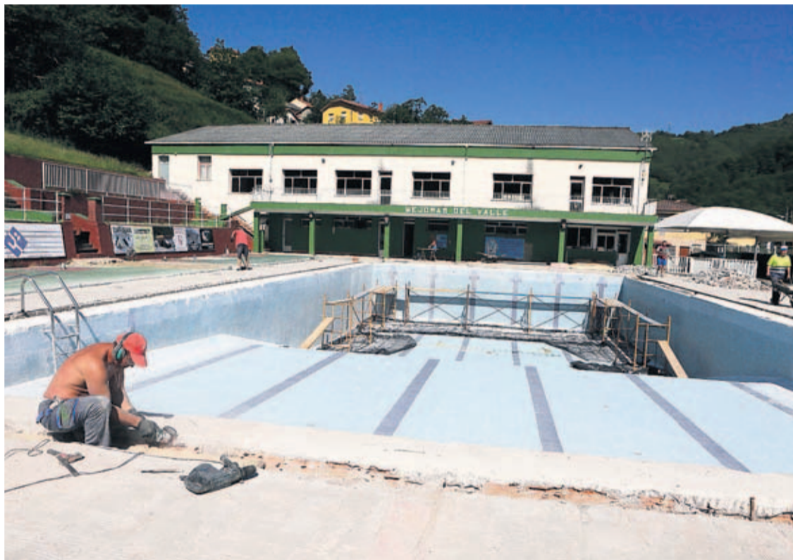
Trabajos de reforma en la piscina de Turón. | Fernando Rodríguez
