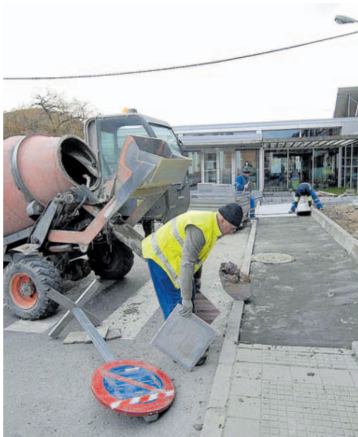
Operarios trabajando en las inmediaciones de la piscina municipal.
