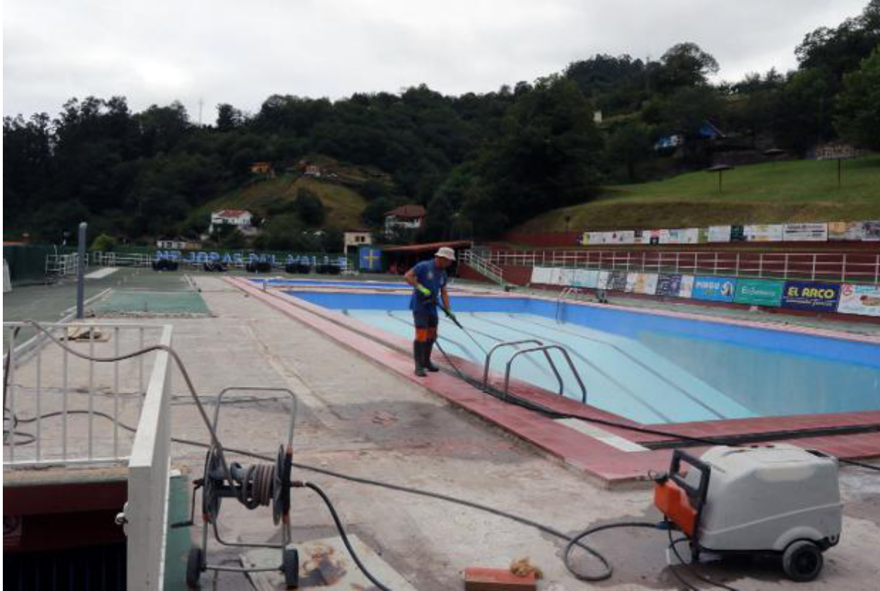
Un operario termina los trabajos en la piscina de Turón para tenerlo todo listo este mes. / JESÚS MANUEL PARDO
