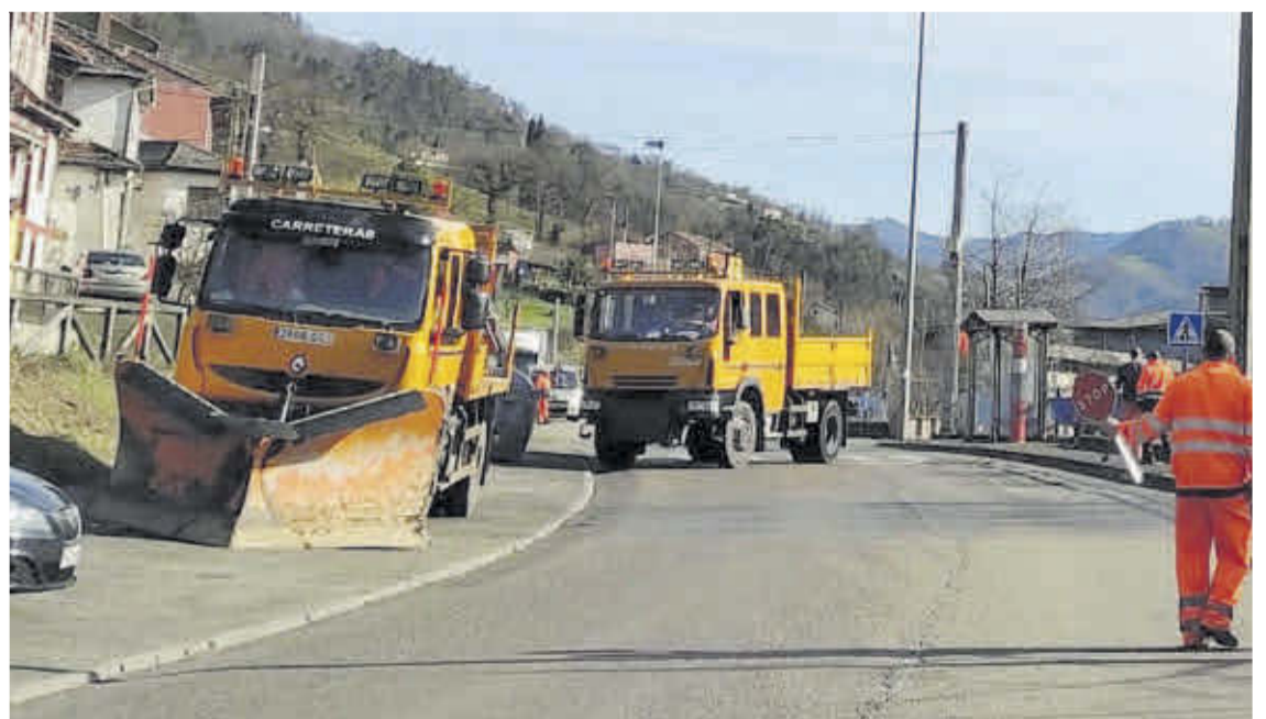
Obras de reparación del firme.
