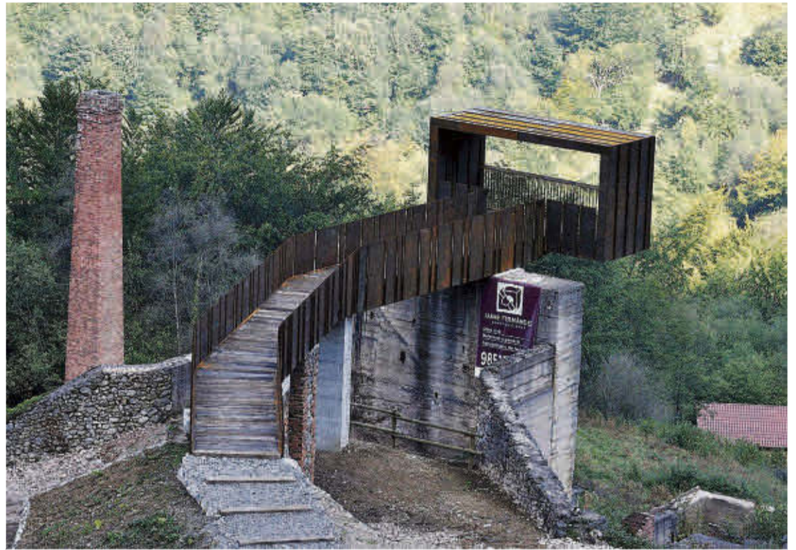
El mirador construido en 2015.
